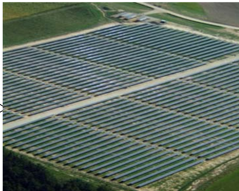
大規模太陽光発電システム
