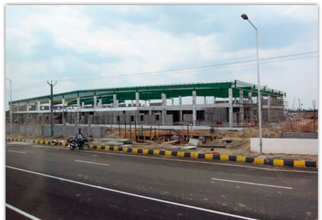
Chennai 郊外の ONEHUB 工業団地
