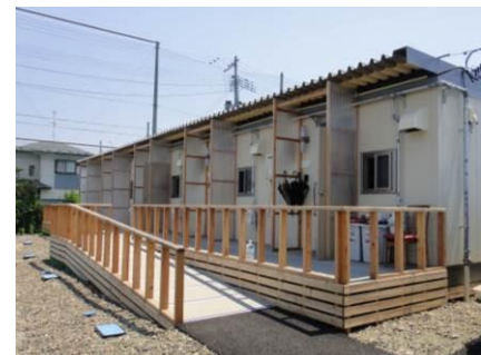
宮城県若林区の応急仮設住宅
