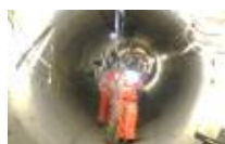
トンネル検査
